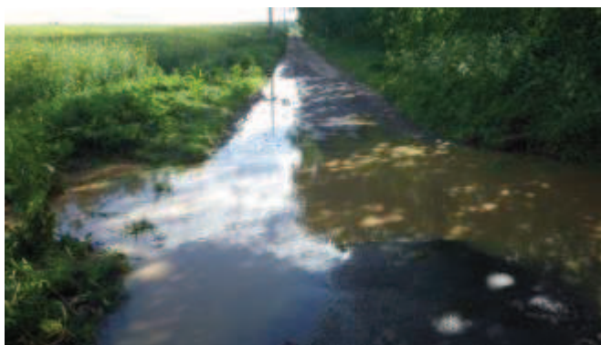
Photographie 5 : Inondation par traversée d'écoulement d'un talweg situé perpendiculairement à une voirie
